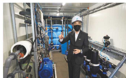
写真左 / 同社の設備を導入した三重県の廃棄物処理プラント 写真右上 / 下水処理場に設置しているバイオガス発電機の一例 写真右下 / 高機能RO膜式排水処理システムは、バイオガス発電プラントから発生する消化液を濃縮し、排水できる安全な処理水と、廃棄する濃縮液に分離処理することで、廃棄物量を大幅に削減する。短時間でユニットを設置できる上、省スペース化で建設コストも削減できる。
